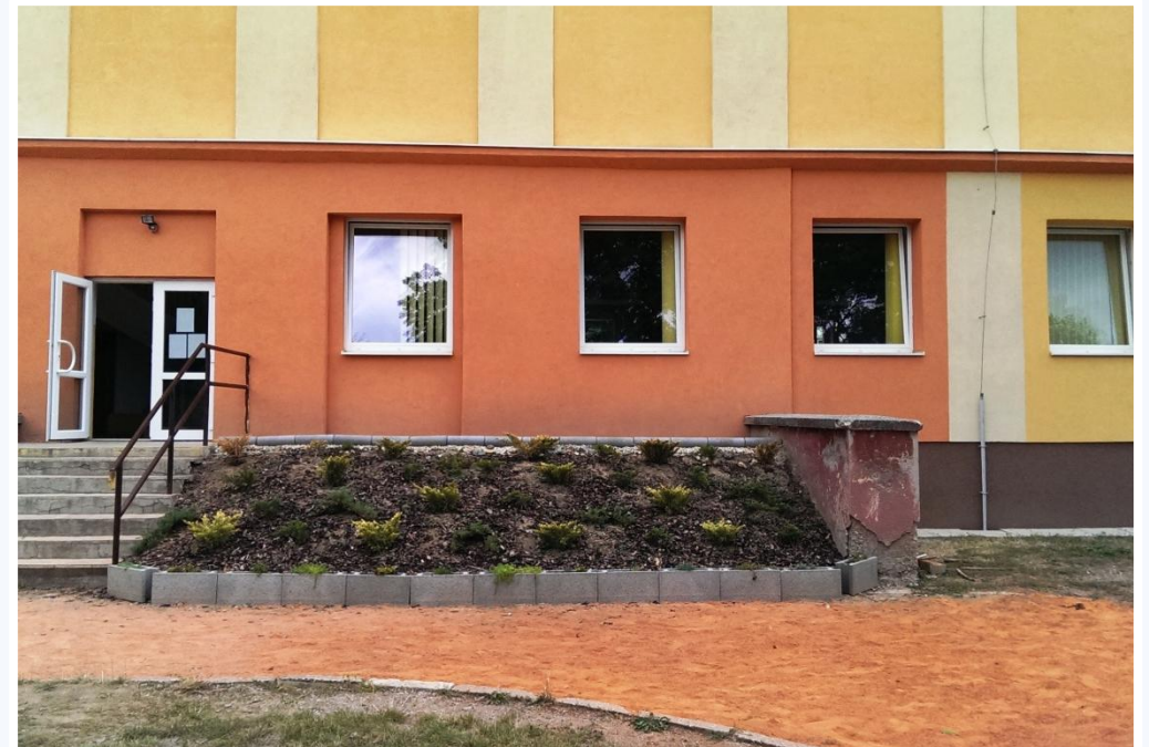
Vstupná časť – súčasný stav rok 2013
